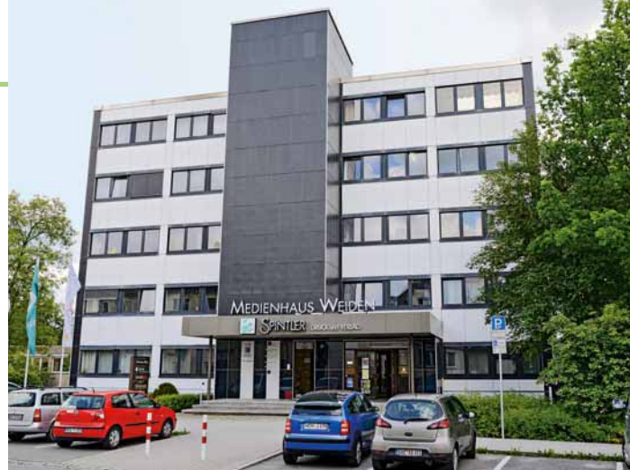
Construit à la fin des années 80, le bâtiment de Spintler Druck und Verlag a depuis été réaménagé à plusieurs reprises pour répondre aux exigences de la production
