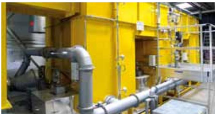
L'unité de traitement des effluents de KBA-CleanAir dispose de trois réservoirs dans lesquels circulent en alternance le gaz brut ou purifié, pendant le nettoyage du troisième réservoir
